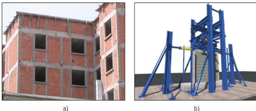
Figura 5. Mampostería confinada. a) Edificación en construcción. b) Dispositivo para la investigación experimental ante cargas laterales cíclicas reversibles en su plano. Fuentes: Elaboración propia
